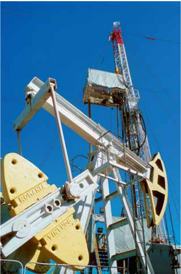
Чтобы увеличить отдачу нефтяного месторождения, не обязательно радикально менять оборудование — достаточно просто прибавить ему «ума»
